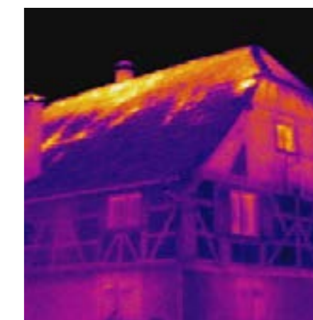
Mantenimiento de Edificio
