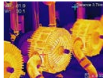
Inspección de equipos mecánicos
